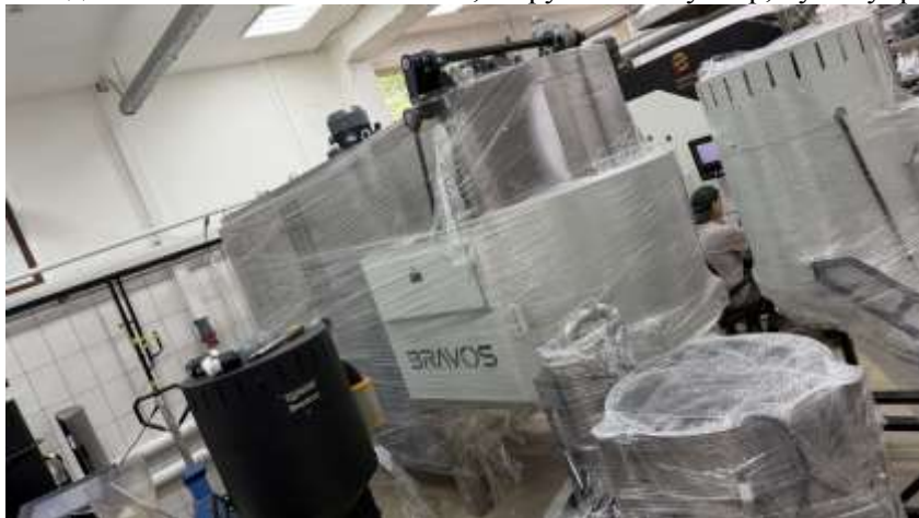
Рис. 1. Ростер «Тайфун-2» Раптор 30, подготовленный к монтажу и пусконаладочным работам
